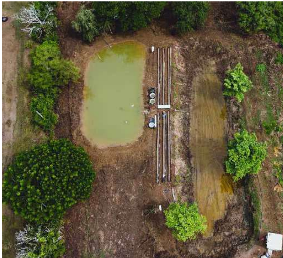
Vista superior del predio Los Ciruelos, obras de mejoras al sistema de recirculación acuapónico comunitario en Repelón, Atlántico.
